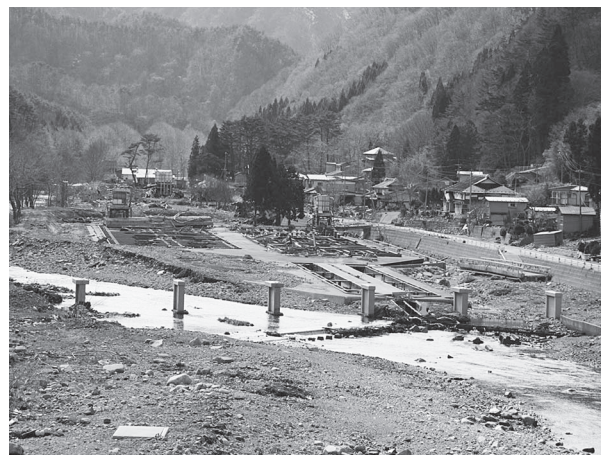
図3 被災後の下安家ふ化場
