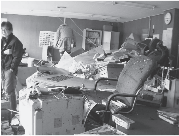
図2 被災した事務室（食品総合研究所）
