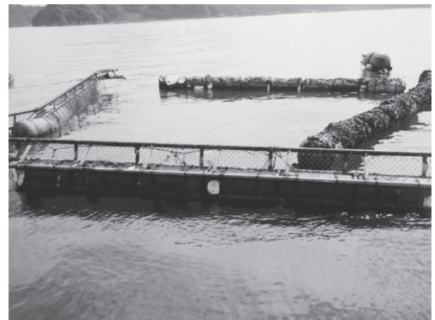
図 2 津波により大破した 11 m 四方の金枠小割筏 野見湾ガラグ漁場にて撮影。
