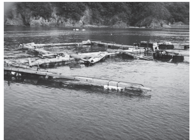
図 1 津波により大破した 10.5 m 四方のカンパチ養殖用木製小割筏 野見湾馬の背漁場にて撮影。
