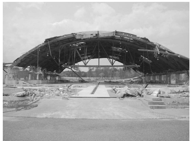
巨大津波により破壊されたヒラメ種苗生産施設
