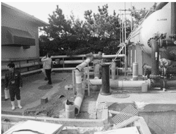
写真3 液状化による被害を受けた茨城県栽培漁業センター
