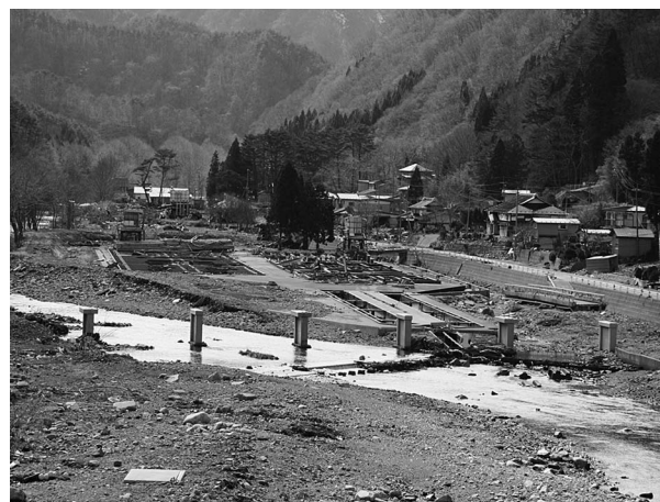
図3 被災後の下安家ふ化場
